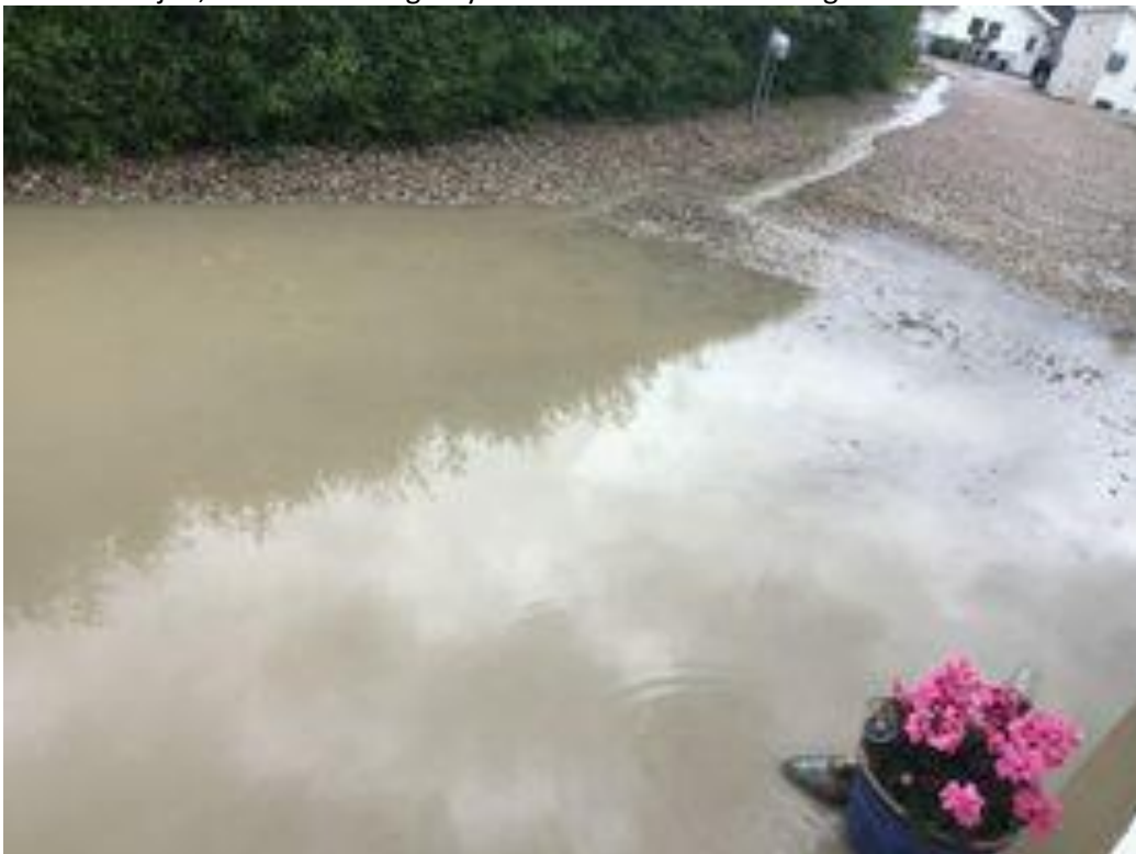
Billede nr. 3: I det øverste venstre hjørne af billedet kan der ses, hvordan der er opstået en rende over tid i vejen, idet der ved regnskyl ledes vand ned mod 6B og 6C.
