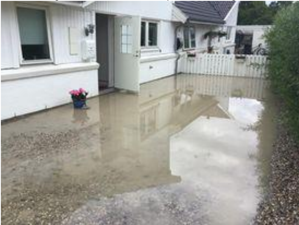
Billede nr. 2: Regnvand ved hoveddøren efter skybrud med efterfølgende vandskader.
